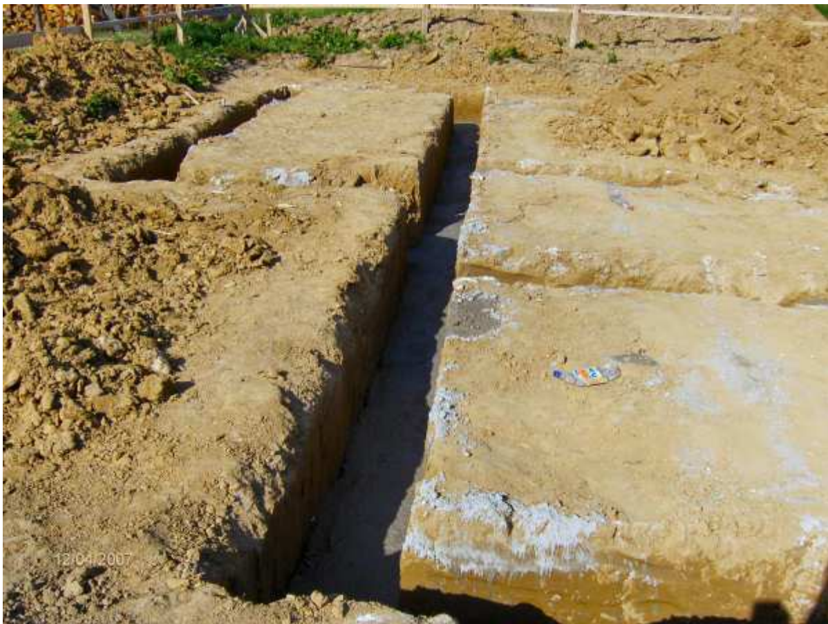
(14.4.2007) Sad je već postavljena i armatura u temelje. Temelji su armirani u "donjoj" zoni sa 3 šipke \phi 16\text{mm} , a u "gornjoj" zoni sa 3 šipke \phi 14\text{mm} . Između su još dvije šipke \phi 10\text{mm} da malo ojačaju cijelu stvar. Na dno armature postavljene su i
