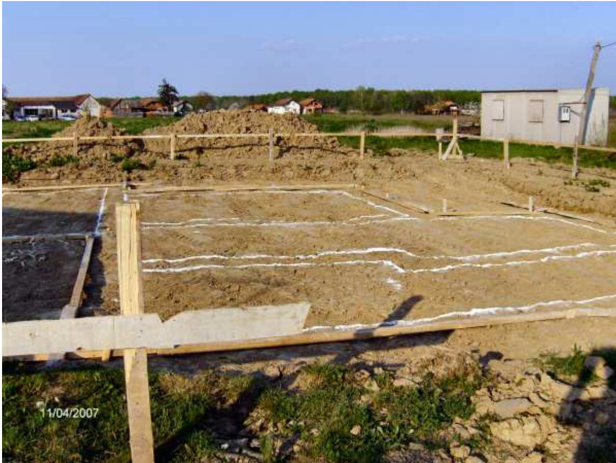
(12.4.2007) Kada su temelji iscrtani na zemlji slijedi iskop temelja i kod mene su na dno stavili malo "mršavog" betona da se napravi nešto ravnija podloga za armaturu i da armatura ne leži baš na samoj zemlji ...
