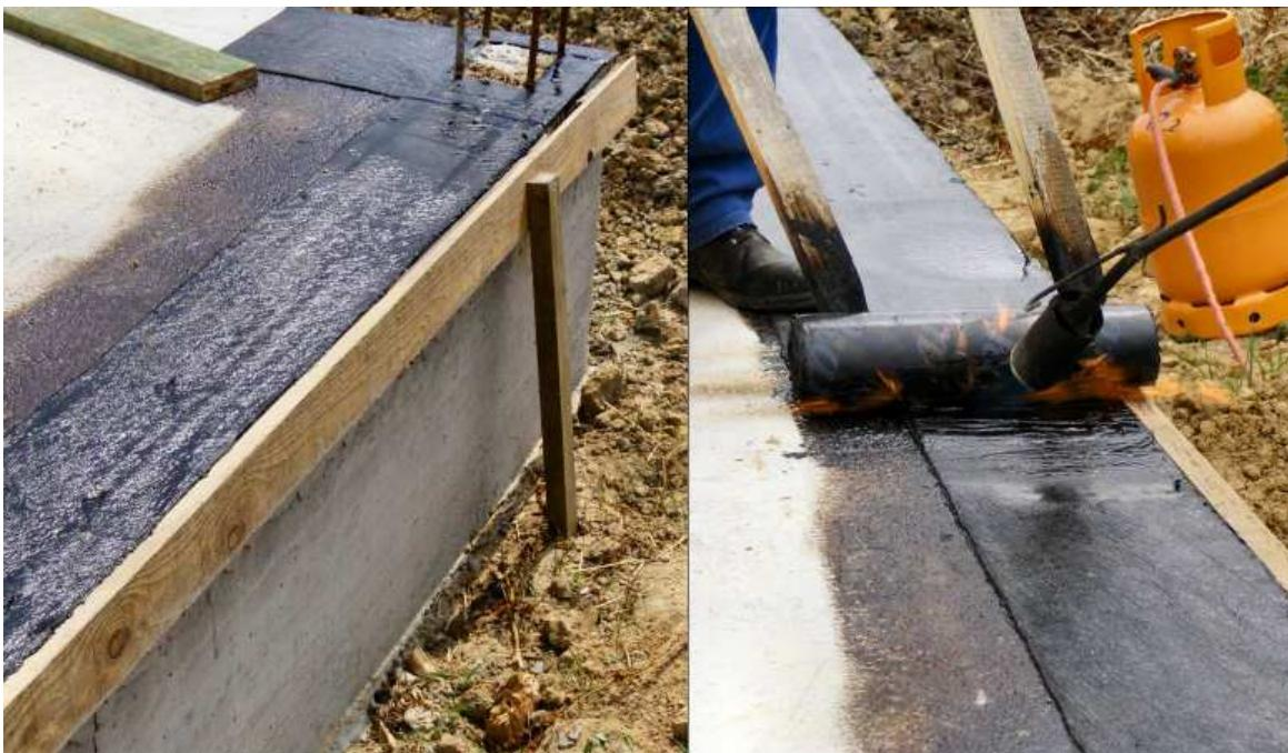
Drugi sloj sam stavljao na preporuku izvođača jer se obično kod zidanja i ostalih unutarnjih radova često potrga sloj hidroizolacije koji viri van zidova pa se onda kod izrade hidroizolacije podova često nema na što zavariti. Ovako ovaj gornji sloj ustvari štiti onaj donji i onda nema problema. U onoj prostoriji koja će biti ispod stepeništa ostavljeno je malo više izolacije da visi. Ona će se zavartiti na vertikalnu izolaciju unutarnjih zidova ...
